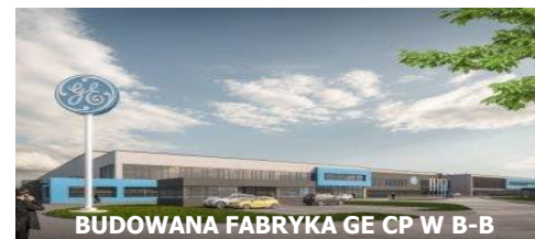
BUDOWANA FABRYKA GE CP W B-B
